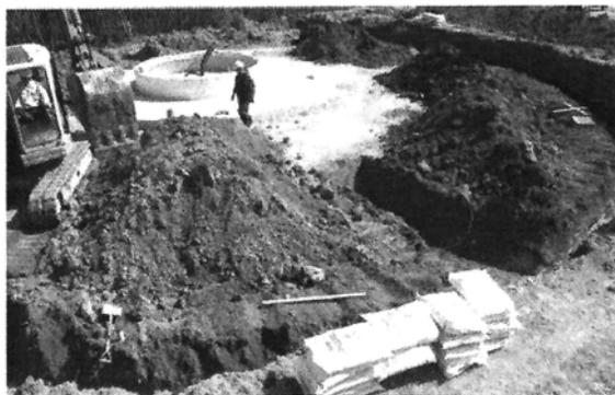
図7 帯状電極による環状接地例
